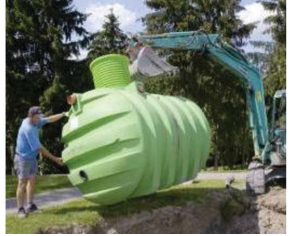
Şekil 19: Plastikten imal edilmiş monolitik toplama deposu / Mall 2011 /
