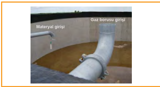
Şekil 3.36: Düşük arıza riskli gaz tahliye düzenekleri; yukarı doğru açılan gaz borusu girişi (solda materyal girişi) [DBFZ]
