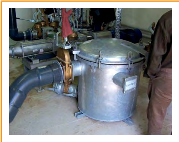
Şekil 3.5: Bir boru hattında ağır materyal tutucu [DBFZ]
