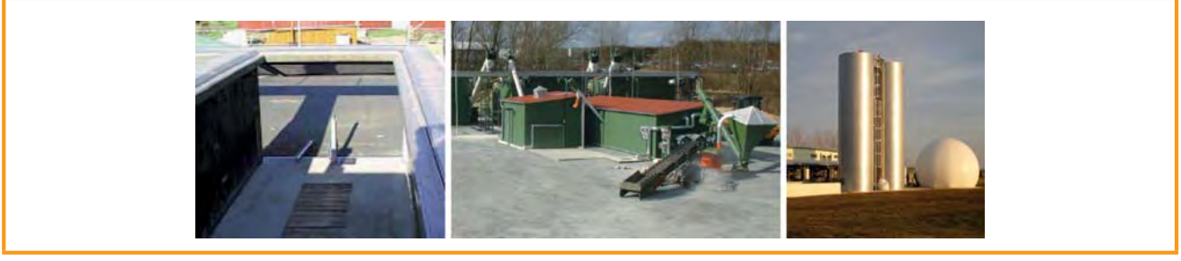
Şekil 3.28: Katı madde fermantasyonunda özel yapı biçimlerine örnekler (solda), karışımli kutu (konteynır) fermentör (ortada), kuru-yaş fermantasyon yönteminin metan basamağı ve harici gaz deposu (sağda) [ATB Potsdam (sol), Mineralit GmbH (orta), GICON GmbH (sağ)]
