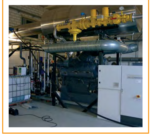
Şekil 6.8: Gaz kontrol hatlı BHKW [DBFZ]
