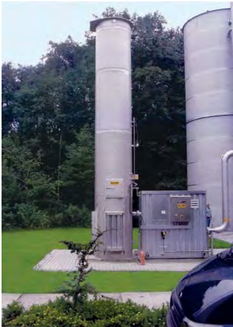
Şekil 3.41: Bir biyogaz tesisinin acil gaz yakma bacası [Haase Umwelttechnik AG]
