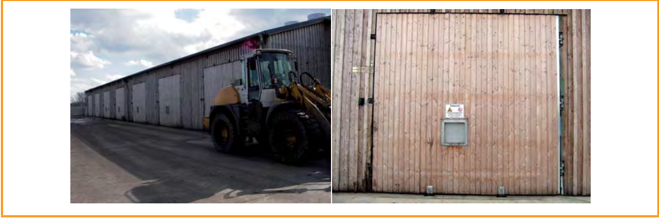
Şekil 3.26: Kutu fermentör (konteynır tip) örneği; fermentör bataryası [Weiland, vTI] ve fermentör kapısı [Paterson, FNR]
